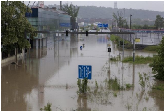
Obr. 3: Povodeň na Rokytce, Praha 8 v červnu 2013
